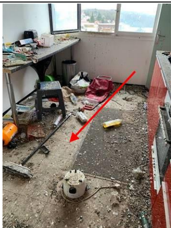
Photo n° PhA001 Localisation : 8ème étage - Cuisine Ouvrage : Substrats et revêtements Partie d'ouvrage : Parties accessibles Description : Sol - Dalles plastiques
