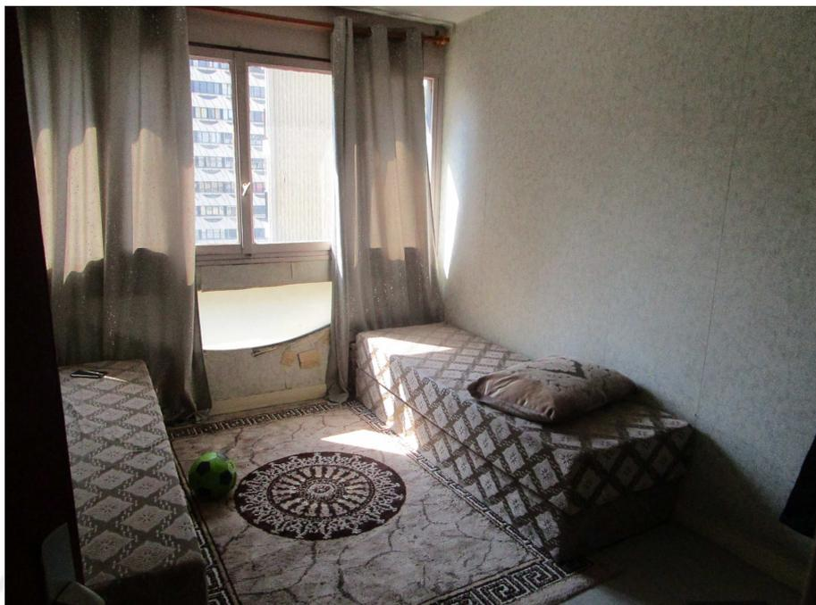
La pièce comporte une baie vitrée, deux pans dormants deux ouvrants, châssis bois simple vitrage, peinture usagée, avec un pan vitré dormant en demi-lune, verre dépoli en partie basse.
