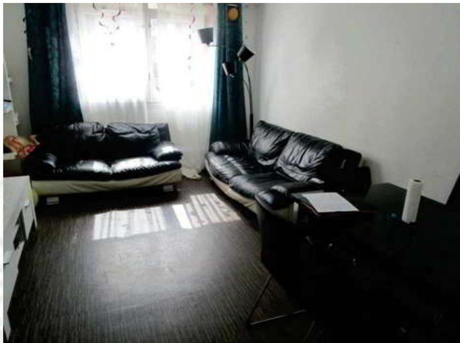
La pièce comporte une baie vitrée, deux pans dormants et deux ouvrants, châssis PVC double vitrage, à l'état d'usage et en bon état de fonctionnement. La baie est sécurisée par des volets pliants métalliques dont la peinture est usagée.
